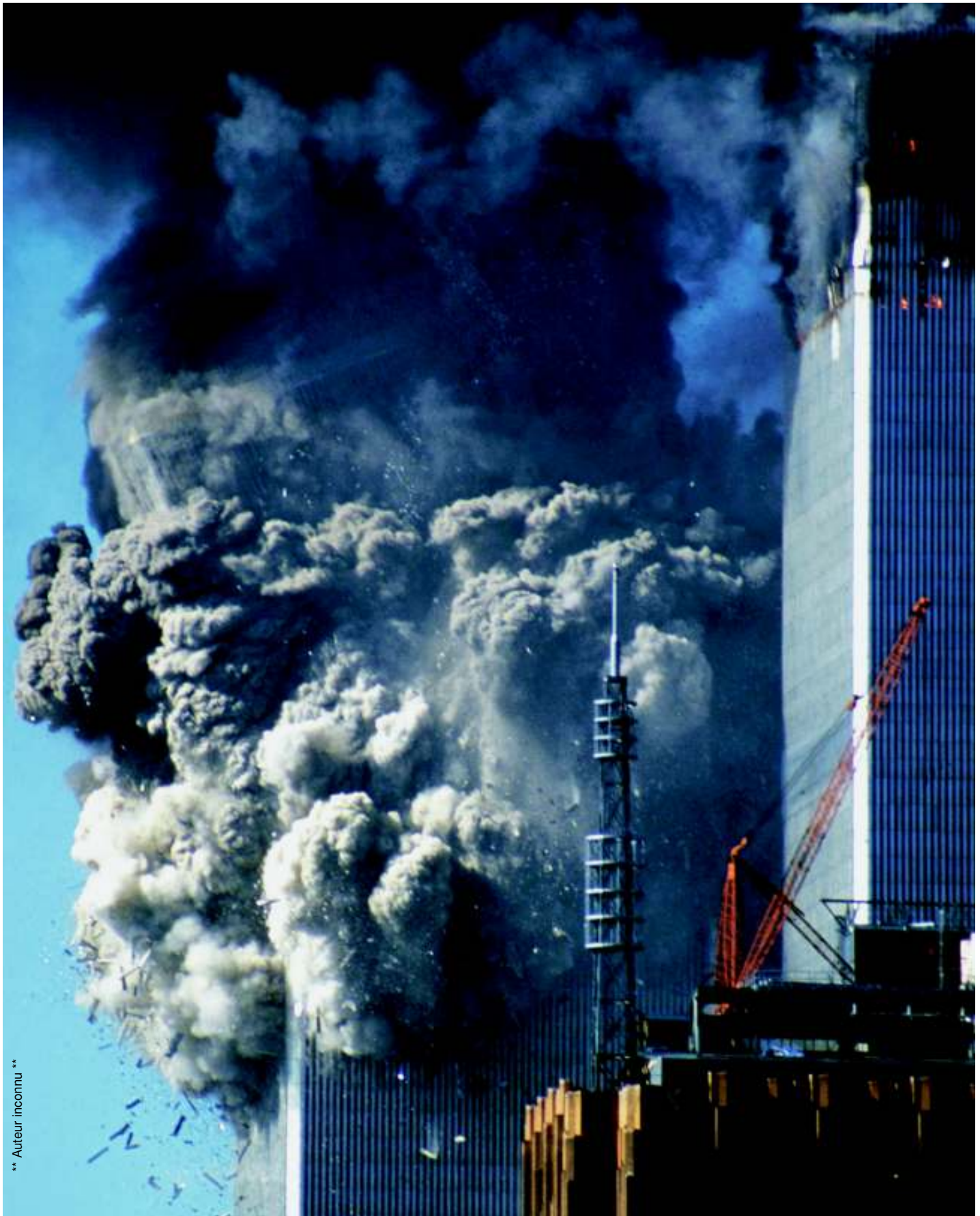
Figure 5-10 La partie supérieure de la tour sud a basculé jusqu'à un angle d'environ 22°. Sur cette photo le sommet de la tour surplombe la base d'environ 23 mètres.
