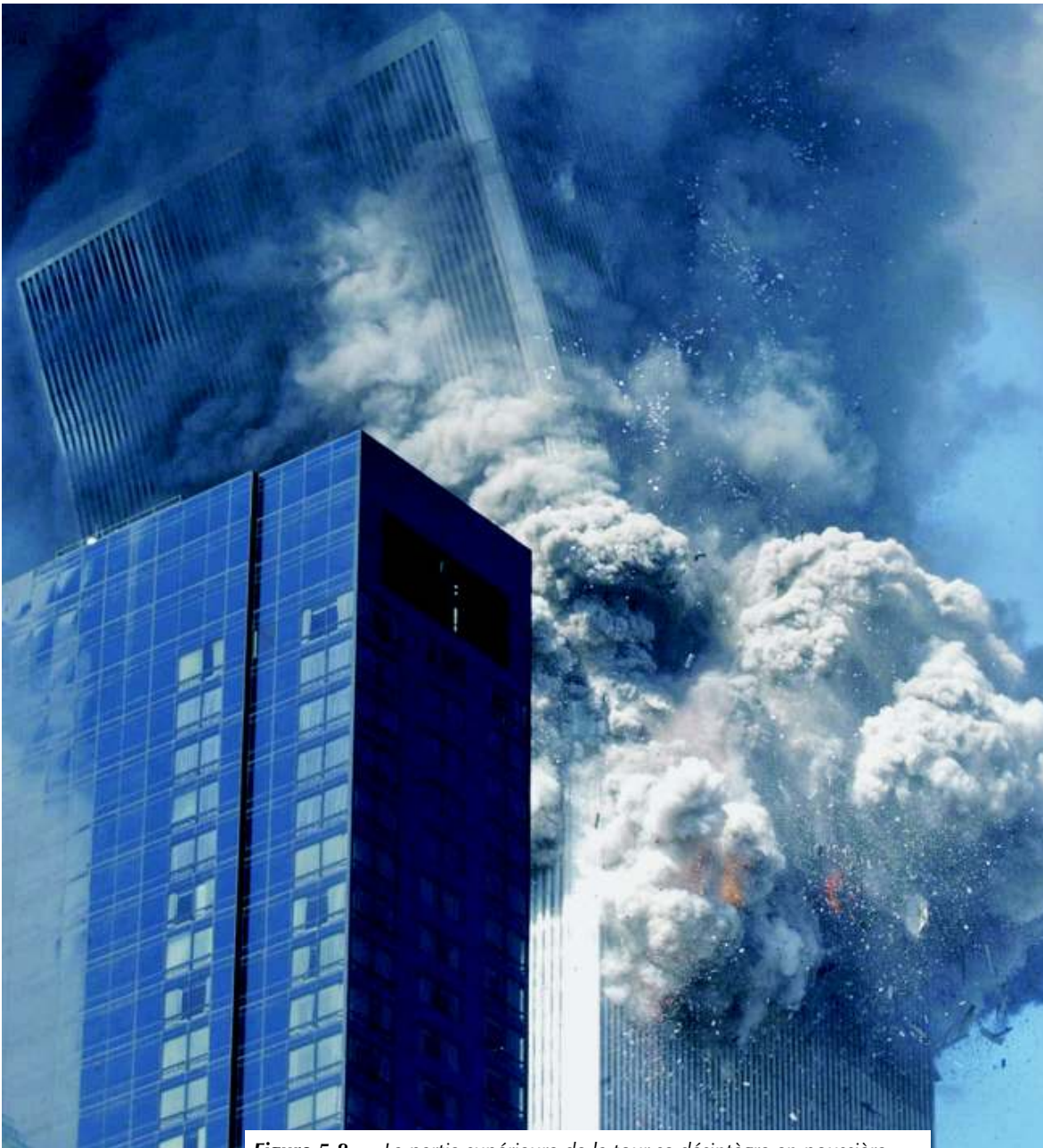
Figure 5-8 La partie supérieure de la tour se désintègre en poussière.
