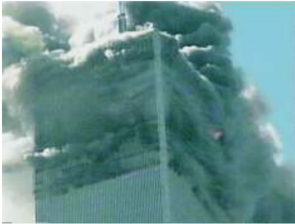
Figure 5-21 Le sommet de la tour nord s'est enfoncé un peu, ce qui signifie que la totalité de la partie supérieure a été sectionnée de la base.
