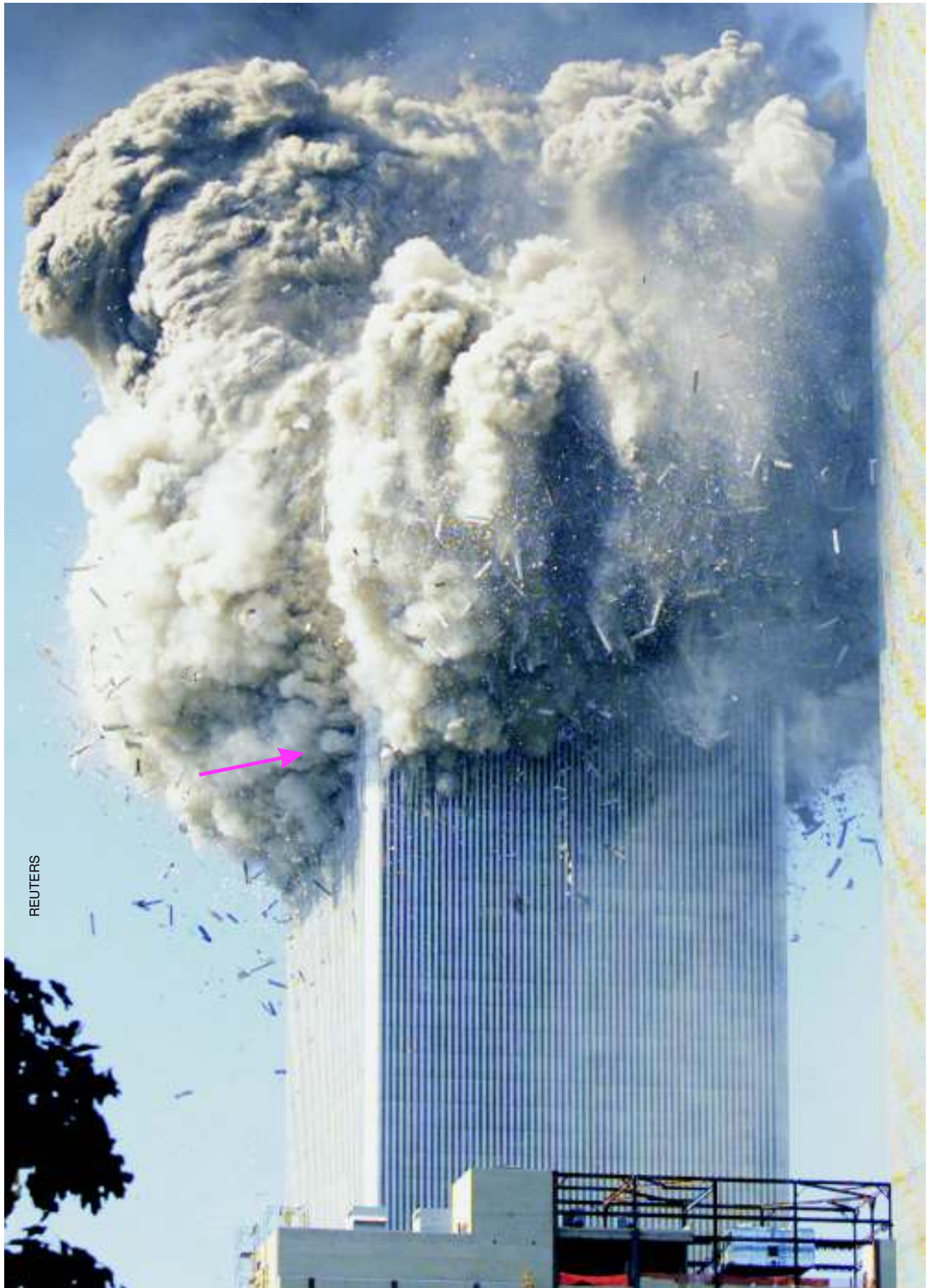
Figure 5-16 La flèche rouge pointe des bouffées de poussière. La signification de la poussière sera discutée au chapitre 7.
